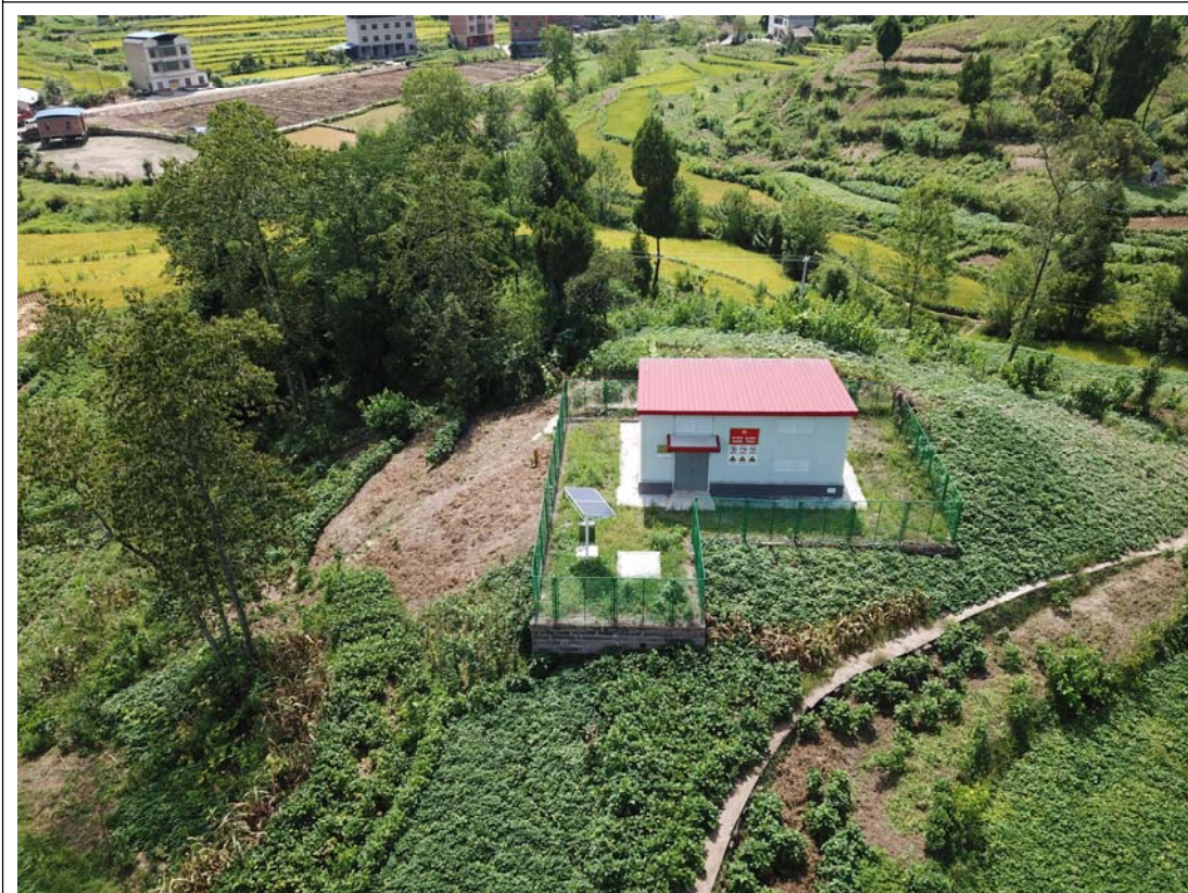
郭村阅室航拍图片
