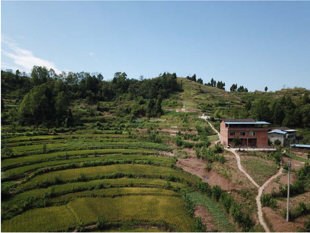
峰汝线 B1 段水土保持设施验收现场图片
