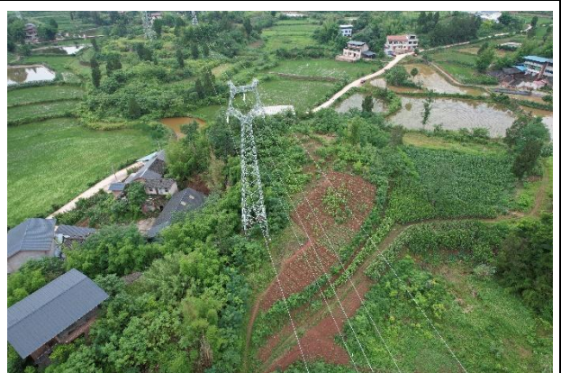
48#铁塔照片及牵张场（复绿）
