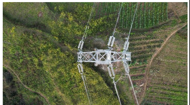
8#塔基道路（复耕）
